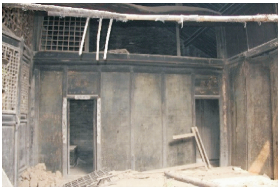
图7 正房西侧的隔板
